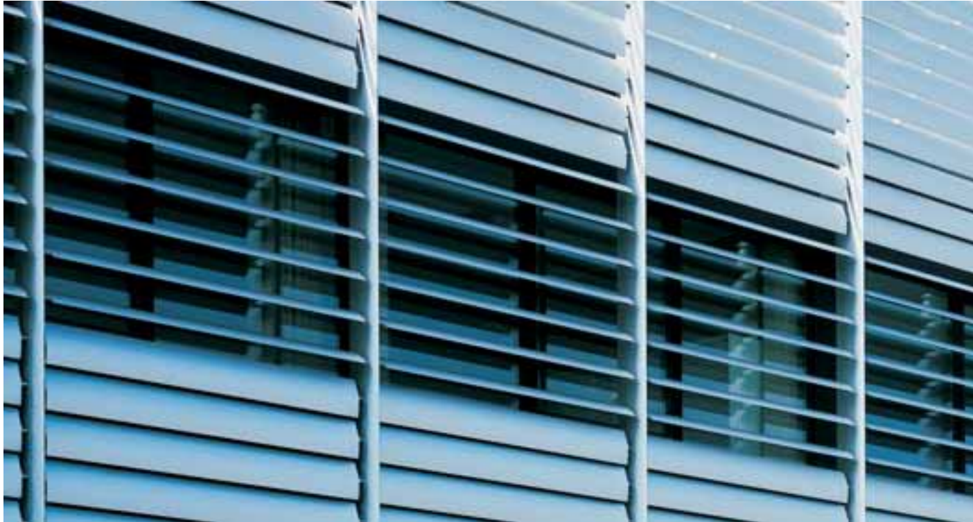
Großlamellen SunControl, Verwaltungsgebäude Padua, Italien Large SunControl louvre blades, Offices, Padua, Italy
