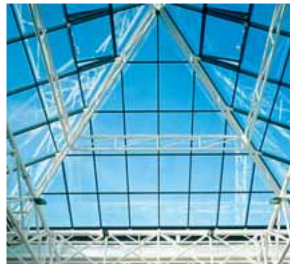
Lichtdach mit Dachfenstern Skylight with roof vents
