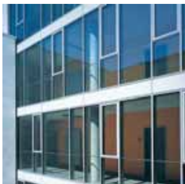
FW 50+.HI Hochwärmegeklämt High level of thermal insulation
