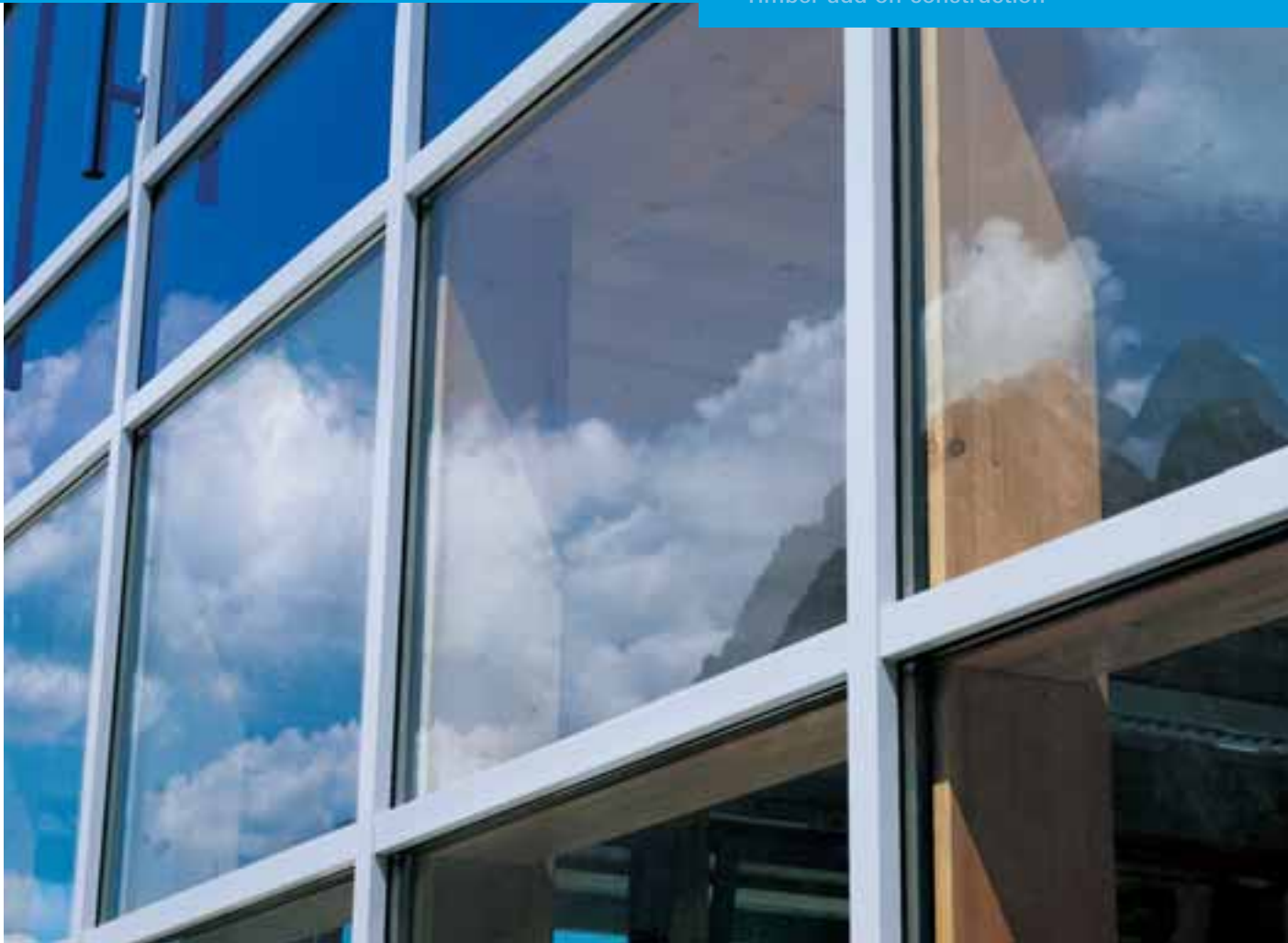
FW 50+AOT Außenansicht View from outside
